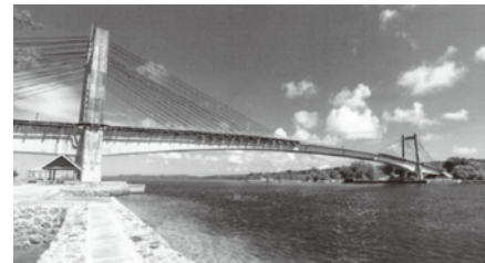
日本・パラオ友好の橋(KBブリッジ)もある。パラオ共和国は親日的な国である。
